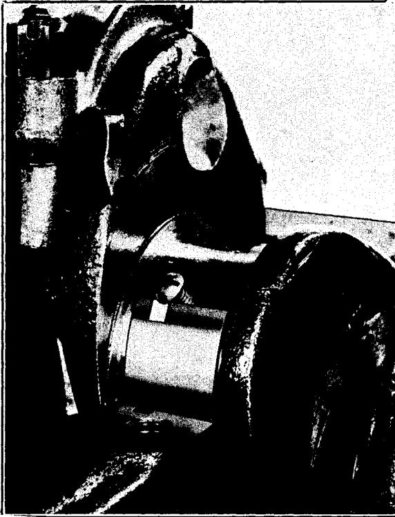
Afb. 14. Het aanbrengen van een nieuwe lagerschaal.
