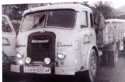
Pegaso Diesel de 140 CV de una empresa cántabra. Su frontal se diferenciaba del modelo de gasolina en el parachoques de igual color que la cabina y en el mayor número de listas horizontales en la calandra.
